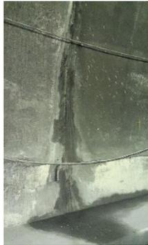
Fotografía 116: K1+445: Chorro entre la junta de dos módulos del revestimiento (12/07/2019)
