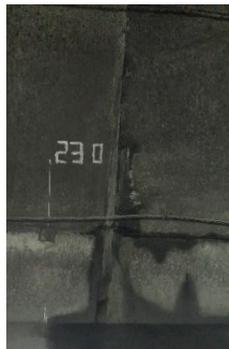
Fotografía 100: K1+230: Humedad en la junta entre el revestimiento y la fase 1 y goteo en la junta entre módulos de revestimiento (12/07/2019)
