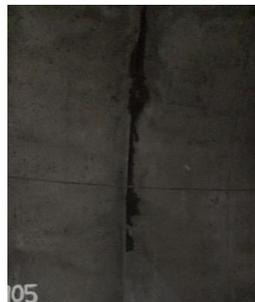
Fotografía 147: K5+903: Humedad en la junta entre módulos del revestimiento (12/07/2019)
