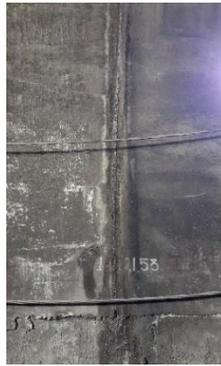
Fotografía 95: K1+213: Humedad en la junta entre módulos de revestimiento (12/07/2019)
