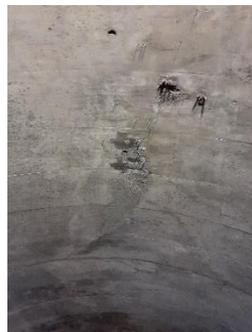
Fotografía 142: K5+850 - K5+848: Goteo entre juntas del revestimiento (12/07/2019)
