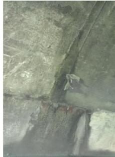
Fotografía 68: K0+440: Humedad entre fase 1 y el revestimiento y chorro entre módulos de revestimiento; geotextil expuesto (12/07/2019)
