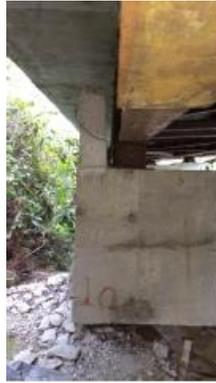
Fotografía 407: Apoyo estructura metálica Eje 3 sin neoprenos.
