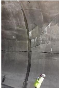
Fotografía 206: K7+955: Chorro en la junta entre dos módulos de revestimiento (12/07/2019)
