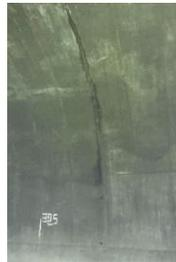
Fotografía 63: K0+327: Flujo de agua entre uniones de módulos (12/07/2019)
