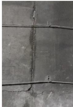
Fotografía 87: K1+061: Humedad entre juntas de los módulos de revestimiento (12/07/2019)
