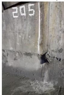
Fotografía 94: K1+205: Goteo en ambos costados entre fase 1 y revestimiento (12/07/2019)
