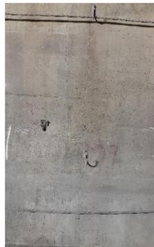
Fotografía 235: K8+505: Resane del revestimiento con deficiente ejecución (12/07/2019)
