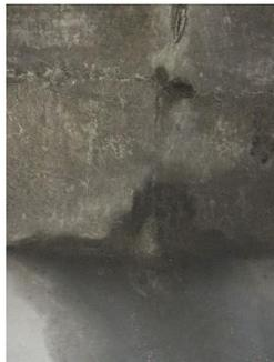
Fotografía 71: K0+475: Goteo en fase 1 y entre juntas de revestimiento (12/07/2019)
