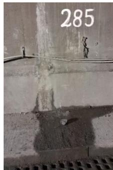
Fotografía 163: K6+286: Goteo en la junta de entre los módulos de revestimiento (12/07/2019)
