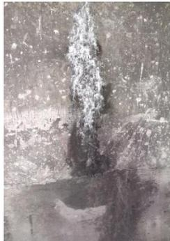
Fotografía 54: K0+169: Goteo cubierto por carbonato de calcio (12/07/2019)
