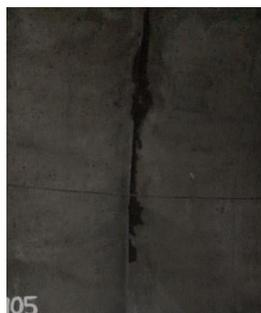
Fotografía 148: K5+915: Humedad en la junta entre módulos y goteo entre la junta de fase 1 y el revestimiento (12/07/2019)
