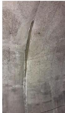
Fotografía 150: K5+952: Flujo entre la junta de dos módulos del revestimiento (12/07/2019)
