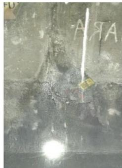
Fotografía 69: K0+450: Humedad entre fase 1 y el revestimiento y goteo entre módulos de revestimiento (12/07/2019)
