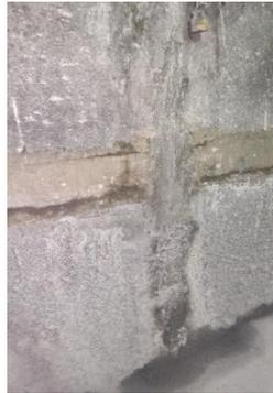
Fotografía 59: K0+240: Humedad en junta entre módulos (12/07/2019)
