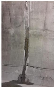
Fotografía 199: K7+895: Goteo en junta de dos módulos de revestimiento (12/07/2019)
