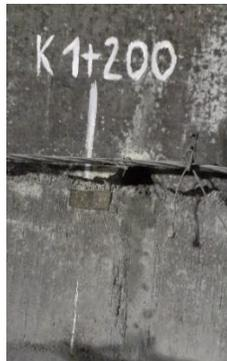
Fotografía 93: K1+200: Huevo entre la fase 1 y la junta con el revestimiento (12/07/2019)
