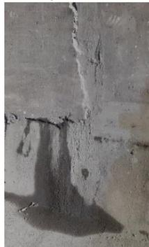
Fotografía 193: K7+810: Goteo en la junta entre fase 1 y el revestimiento. (12/07/2019)
