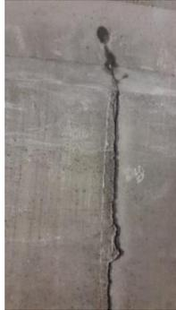
Fotografía 167: K6+565: Goteo en la junta entre módulos de revestimiento (12/07/2019)
