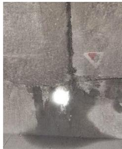
Fotografía 67: K0+430: Humedad entre fase 1 y revestimiento y chorro entre unión de los dos módulos (12/07/2019)
