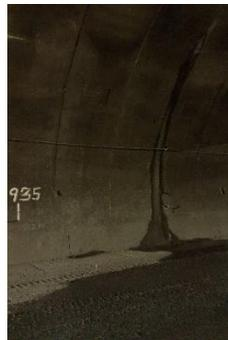
Fotografía 204: K7+930: Chorro en junta de dos módulos de revestimiento (12/07/2019)
