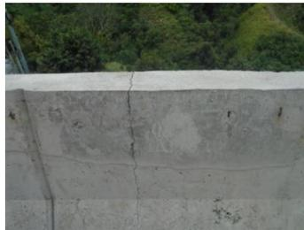
Fotografía 415: Fisuras en las barreras de tráfico - Puente La Julia.
